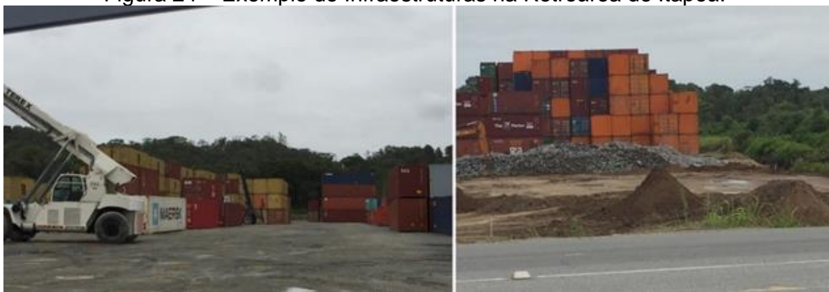
Figura 24 – Exemplo de Infraestruturas na Retroárea de Itapoá.
