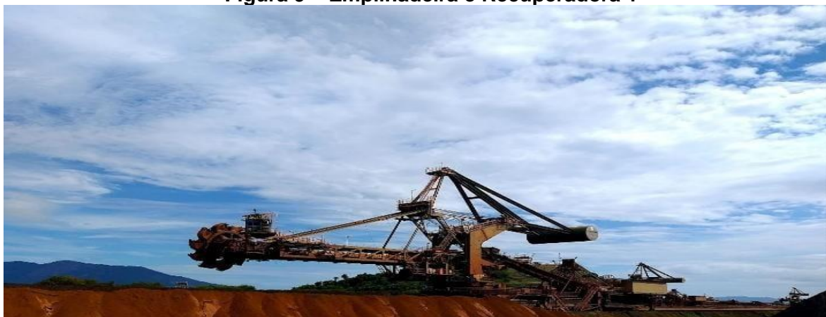
Figura 9 – Empilhadeira e Recuperadora 1
