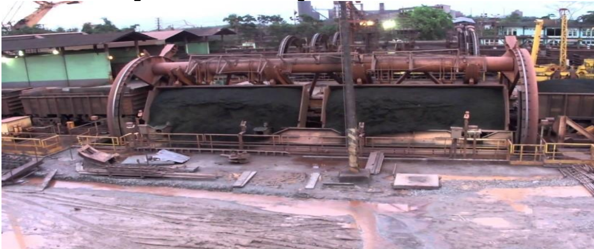
Figura 5 – Virador de vagões em funcionamento
