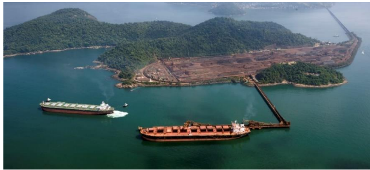
Figura 4 - Terminal Ilha Guaíba Fonte: Vale Portos Sul - Vale S.A.
