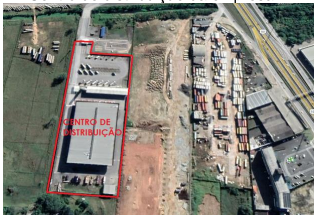
Figura 7 - Centro de distribuição da empresa AMBEV em Itajaí
