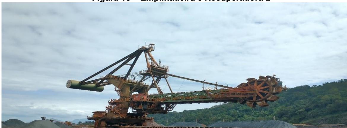
Figura 10 – Empilhadeira e Recuperadora 2
