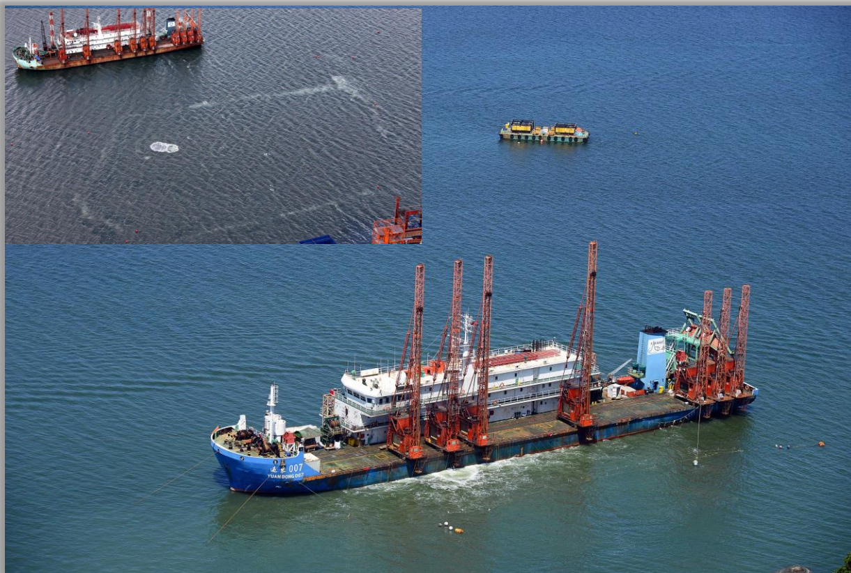
Derrocamento com explosivos/Massa expansiva – Bacia de evolução PSB
